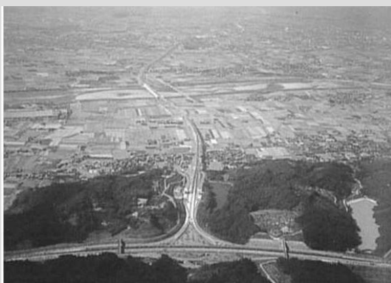
四国縦貫自動車道、今治小松自動車道
