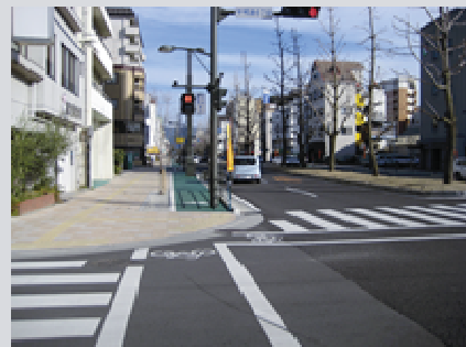
歩道のバリアフリー化及び カラー舗装による自転車通行帯の分離
