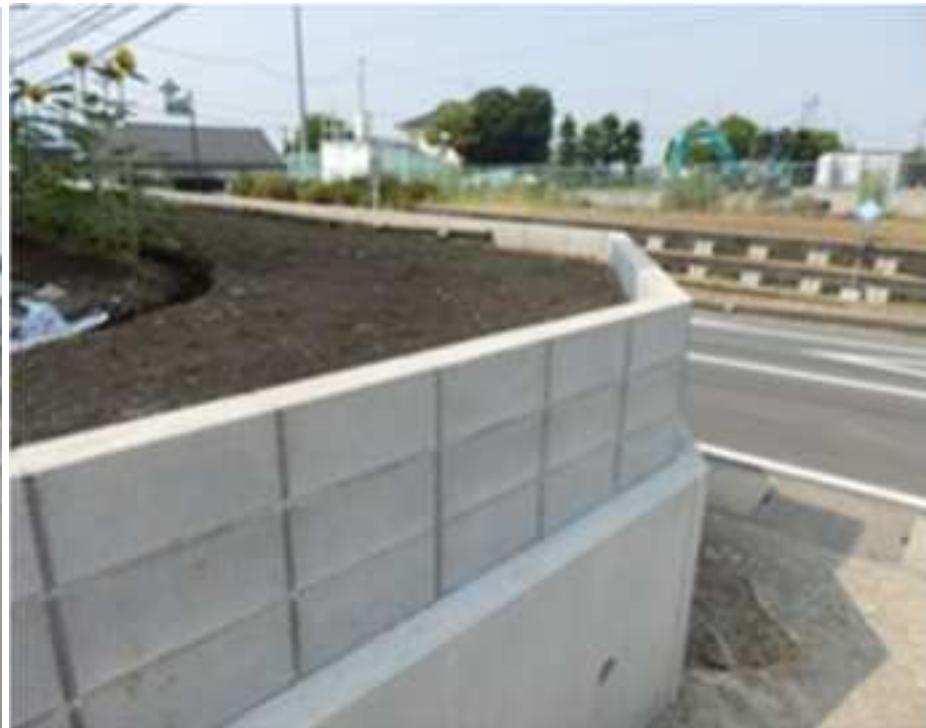
ブロック塀を土留めとして使用
