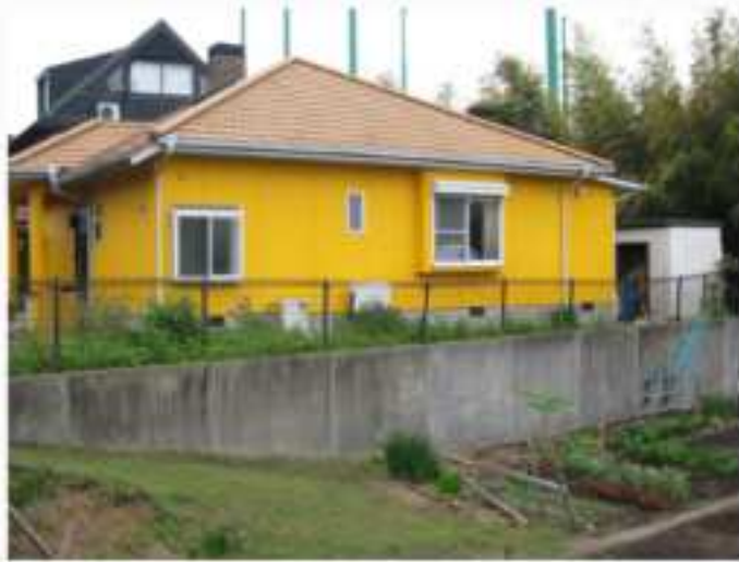
コンクリート擁壁（益城町）
