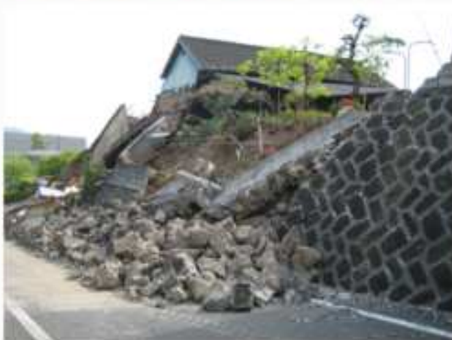
練積擁壁(益城町)
