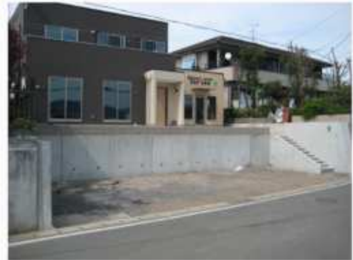
コンクリート擁壁（益城町）
