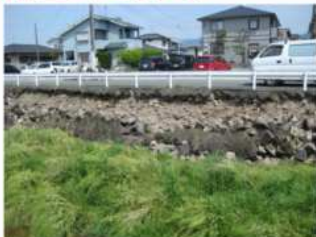
練積擁壁(益城町)
