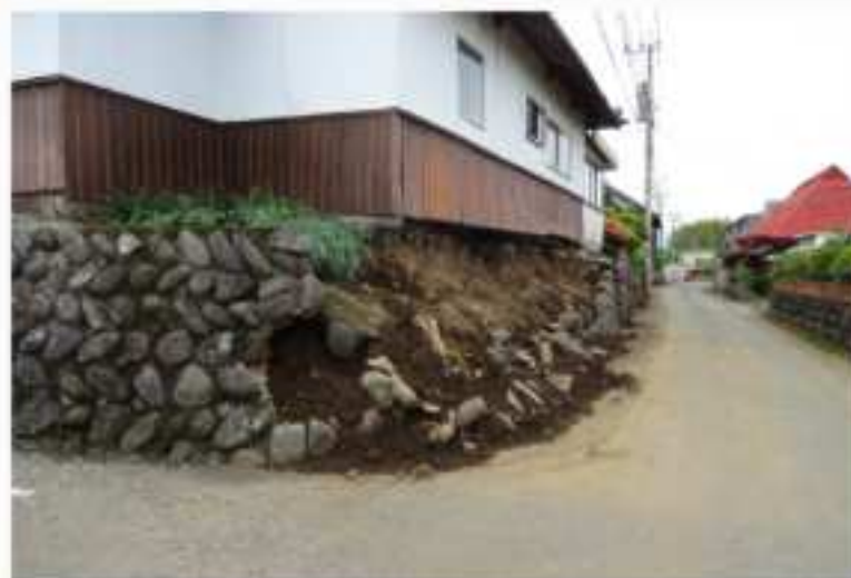
空積擁壁(大津町)
