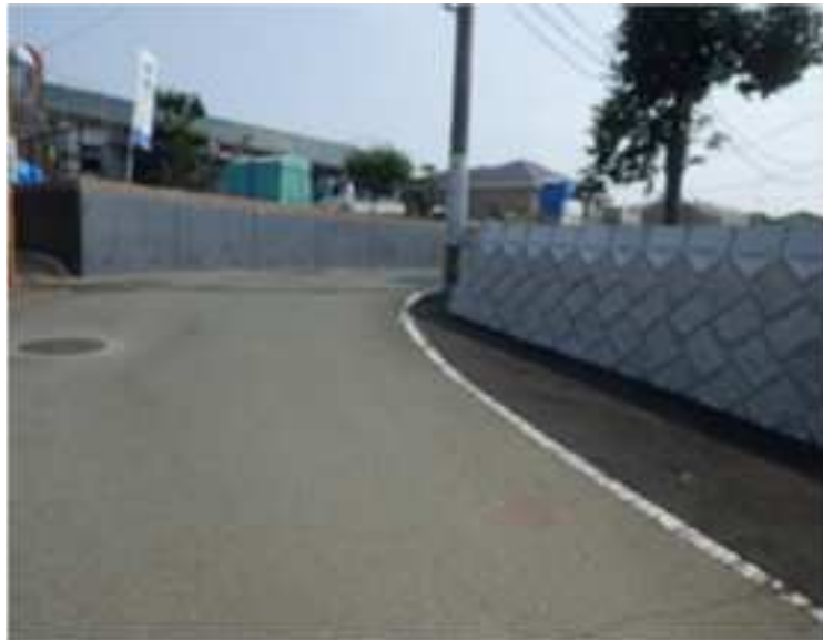
プレキャストL型擁壁(左)、ブロック積み(右)
