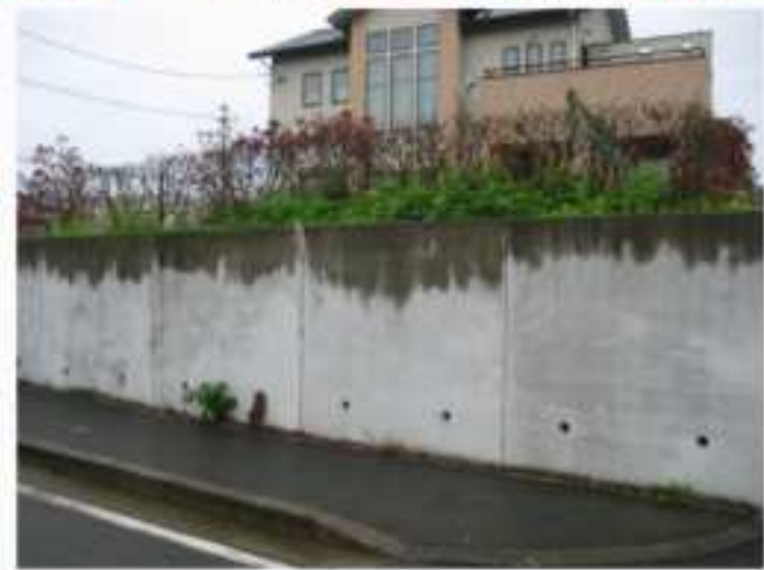
コンクリート擁壁（御船町）
