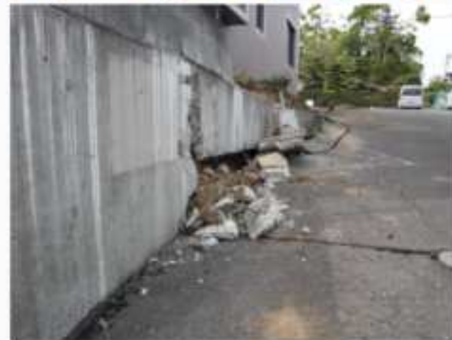
コンクリート擁壁(益城町)
