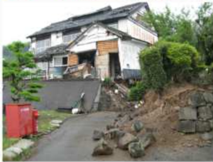
コンクリート擁壁（御船町）
