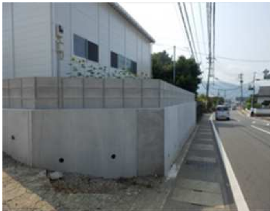
プレキャストL型擁壁＋ブロック塀
