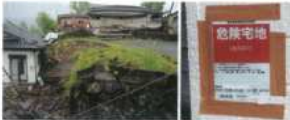
左は、宅地帯の崩壊などが目立つ被災地益城町の被災状況。右は、「危険宅地」の判定士が立ち入り禁止の宅地を調査する様子。左は日経コンストラクション
