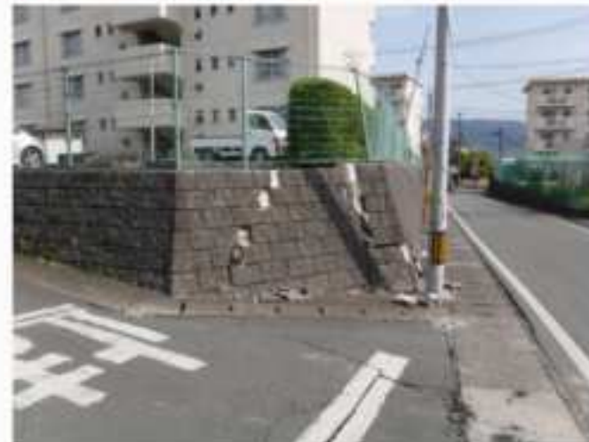
練積擁壁(益城町)
