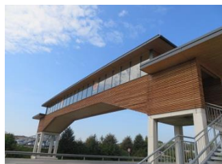
CLT 造の歩道橋 (オーストリア)
