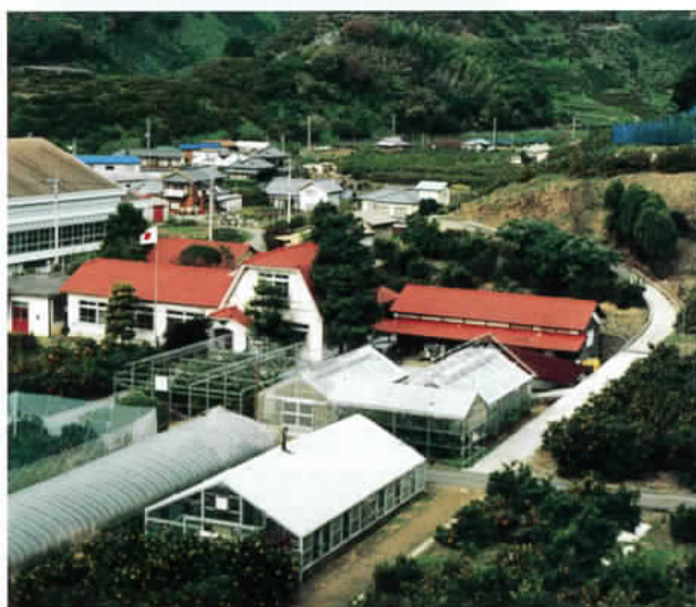
南予分場建物施設
