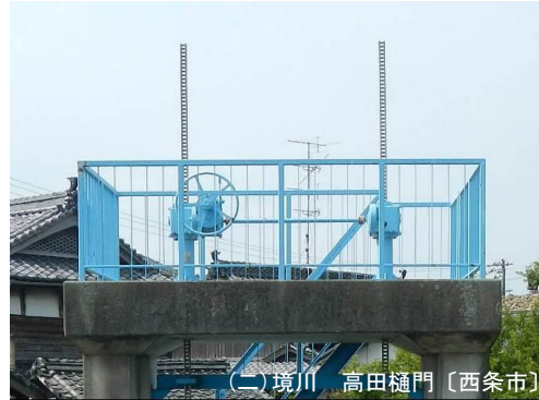
開閉装置（ワイヤロープ油圧シリンダ式）
