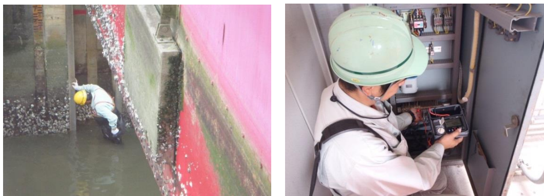
図-解 1.1 河川用機械設備点検状況（事例）
