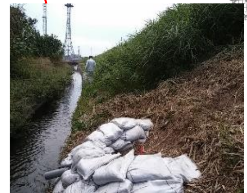
左岸4k/6付近
