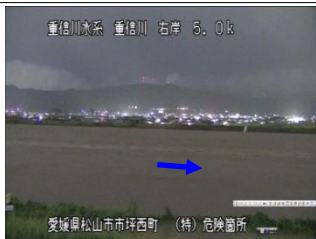
重信川 5.0k付近 (特) 危険箇所
