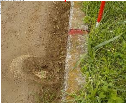
左岸1k/5付近
