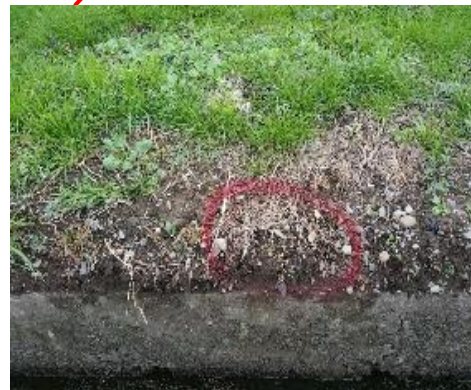
左岸3k/2付近
