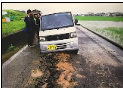
北川原地区道路崩壊(液状化)による車両落下
