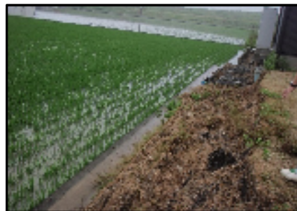
塩屋地区住宅敷地一部崩落
