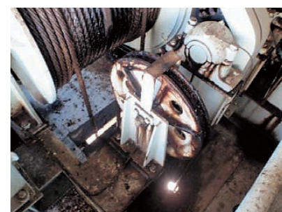
(本谷川水門) S54年度建設
