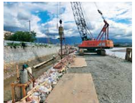
(二)国領川（新居浜市）堤防耐震対策工事
