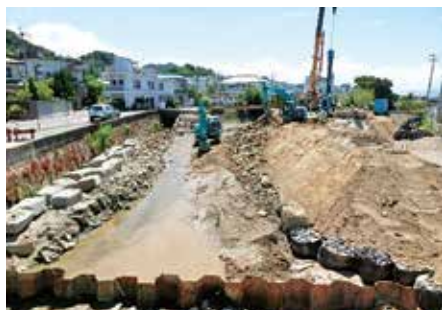
改修前 (工事中)
