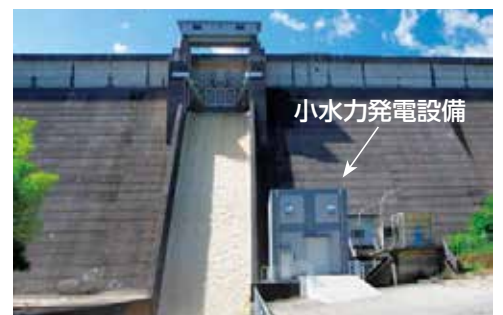
クレストゲートから放流を行っている玉川ダムと平成29年1月から運転している小水力発電設備
