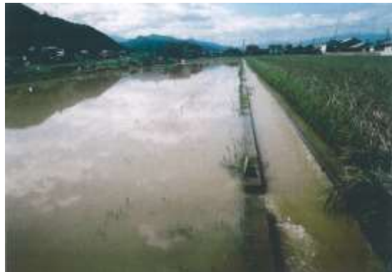
浸水状況(上流部)
