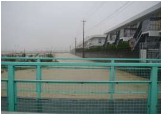
浸水状況(国道11号下流)
