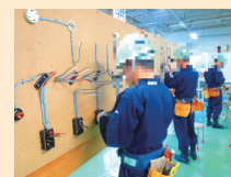
▲電気通信設備科
