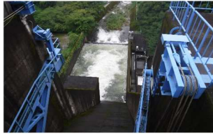
【ダム放流】 須賀川ダムのゲートから放流しています。
