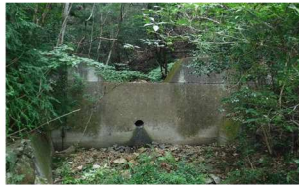
【治山谷止A】 平成13年に完成したコンクリートの谷止工です。
