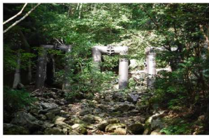
【治山谷止B】 平成14年に完成した鋼製スリット製の谷止工です。
