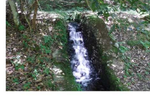
【柿原水源池公園】 洗い堰から水路で公園に引水しています。
