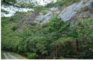
【原石山】 ダム建設は、この山の岩石を採取、粉砕して、コンクリート用の骨材を生産しました。
