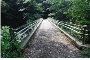
【鮎返橋】 昭和51年に完成した長さ41m、道路幅2mのコンクリート橋です。
