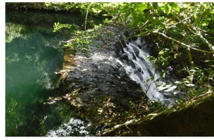
【洗い堰】 大正15年に完成した取水堰で、直下の柿原浄水場で浄化した市内に給水しました。
