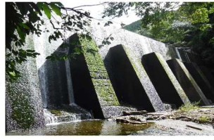
【第二貯水池堰堤】 昭和26年に完成した高さ15m、長さ56m、貯水量9万m3の堰堤です。(南予遺産に選定)
