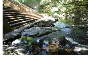
【柿原水源池公園】 支流正し川と階段式の親水護岸です。
