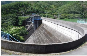
【須賀川ダム】 昭和51年に完成した高さ40.2m、長さ159.5mの多目的ダムです。
