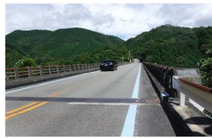
【新折付橋】 昭和50年に完成した長さ120m、道路幅8.7mの鋼製アーチ橋です。
