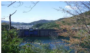
【須賀川ダム】 ダム記念公園から須賀川ダムを望みます。
