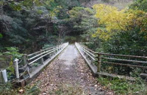
【鮎返橋】 昭和51年に完成した長さ41m、道路幅2mのコンクリート橋です。
