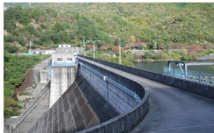
【須賀川ダム】 昭和51年に完成した高さ40.2m、長さ159.5mの多目的ダムです。
