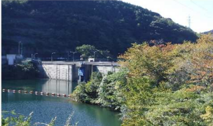
【須賀川ダム】 須賀川ダムの裏側と若山湖です。
