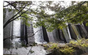
【第二貯水池堰堤】 昭和26年に完成した高さ15m、長さ56m、貯水量9万m3の堰堤です。(南予遺産に選定)
