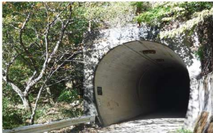
【梨ノ木谷隧道】 延長92m、幅3.5mのトンネルで、線形はS字状にカーブしています。
