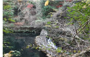
【洗い堰】 大正15年に完成した取水堰で、直下の柿原浄水場で浄化した市内に給水しました。
