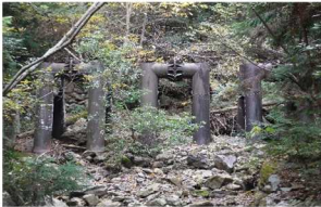
【治山谷止B】 平成14年に完成した鋼製スリット製の谷止工です。
