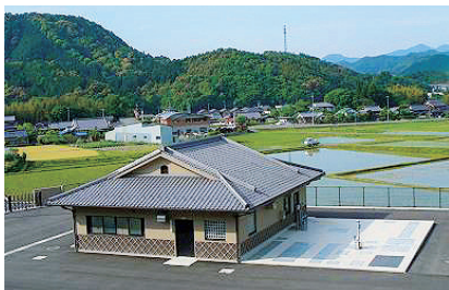
生活排水等を農業用水に循環利用する農業集落排水処理施設 (鬼北町 奈良地区)
