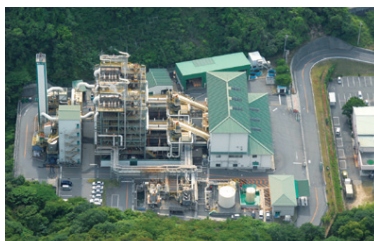
愛媛県廃棄物処理センター
