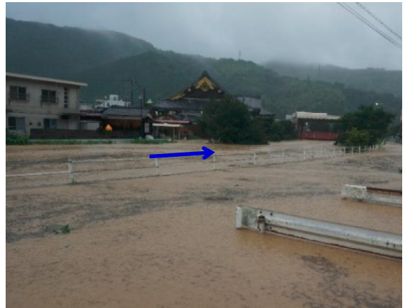
(二) 立間川水系河内川 (宇和島市) 平成 30 年 7 月 西日本豪雨
