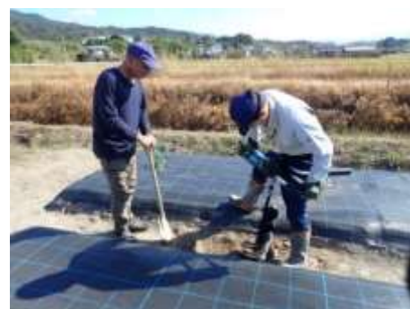
穴掘り機を用いた排水性改善
