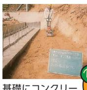
基礎にコンクリートを入れ、アンカーボルトを設置。
