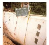
コンクリート養生後、裏型枠を撤去する。
