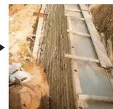
組み立て完了後、コンクリートを打設し、養生する。
