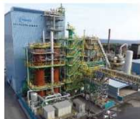
12m 3 小規模試験高炉(水素還元)
