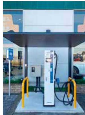
EV 用急速充電器
