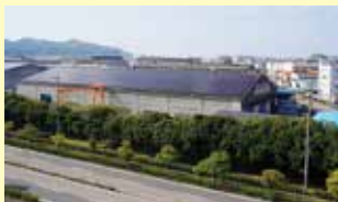
太陽光パネルの設置
