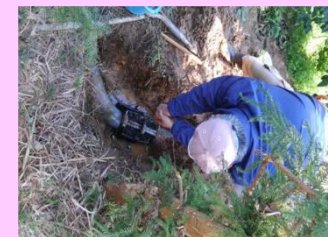
【パイプラインの補修】
