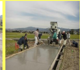
【農道の簡易舗装】
