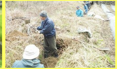
【復旧作業の様子】
