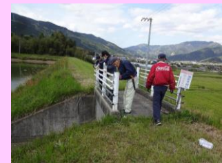
【転落防止施設の補修】
