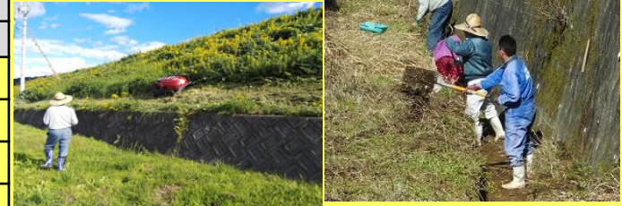
【ラジコン草刈り機を用いたため池法面の草刈】
