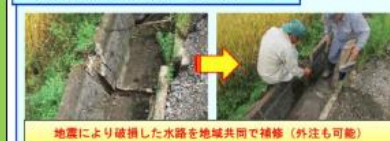
地震により破損した水路を地域共同で補修（外注も可能）
