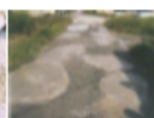
農道の窪みの補修
