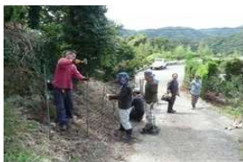
【防護柵の設置】
