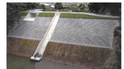
初ヶ谷池の改修状況（吾川地区）
