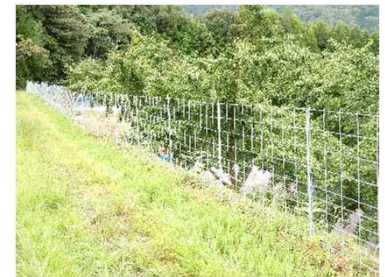
ワイヤーメッシュ柵による侵入防止対策
