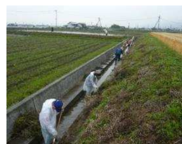
水路の泥上げ
