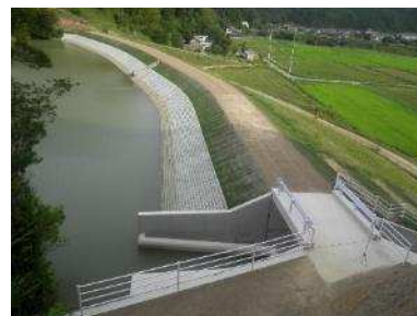
ため池の改修
