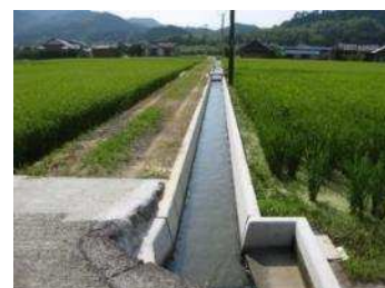
農業用排水路
