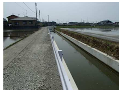
湛水防除（導水路）
