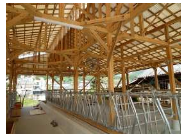
牛舎の補改修
