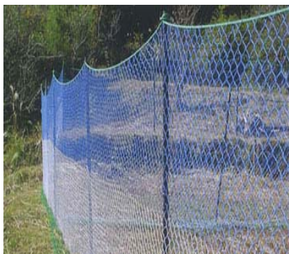
シカ侵入防護柵
