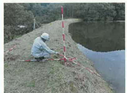
ため池の点検状況
