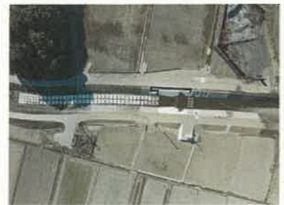
取水堰の改修
