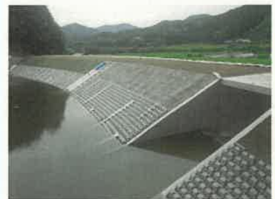
ため池の改修
