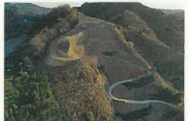
再編復旧工事中
