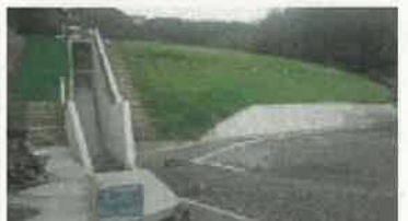
ため池の改修整備
