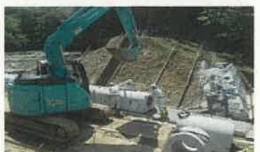
ため池改修工事中
