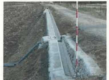
槇の川地区の水路整備状況
