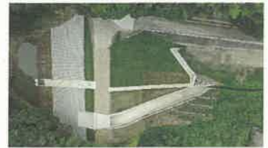
改修工事が完了した初ヶ谷池 （吾川地区）
