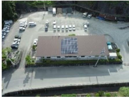
太陽光発電システム
