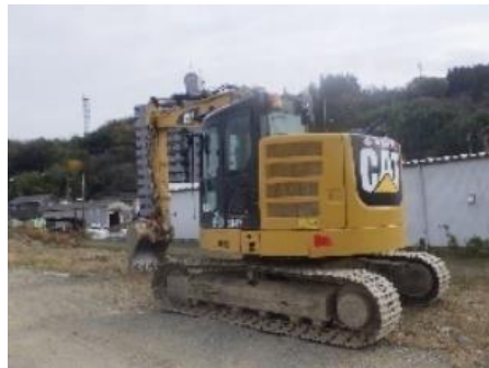
土嚢製作・設置用重機 (0.45 m 3 )
