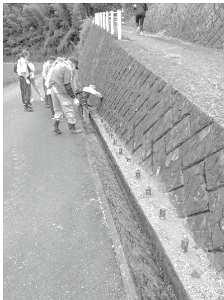
写真7 百八灯の設置
