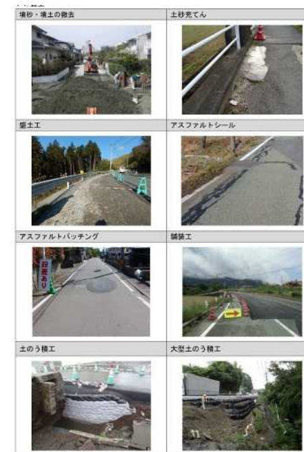
応急復旧工法事例集(一部掲載)
