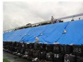
熊本地震でパターン化されている応急復旧工法
