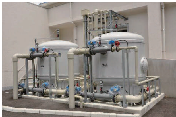
写真1 飼育水を循環利用するためのろ過機
