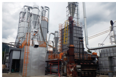
木質バイオマス発電所
