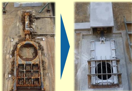
ダム取水ゲートの更新
