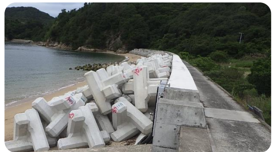
堤防の嵩上げ (上島町：佐島東地区)
