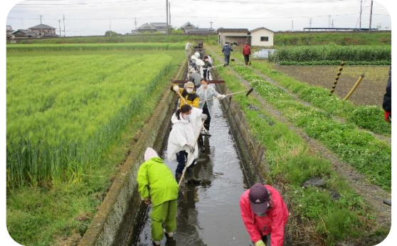
水路の泥上げ (松前町)
