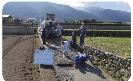
農道の舗装 (四国中央市)
