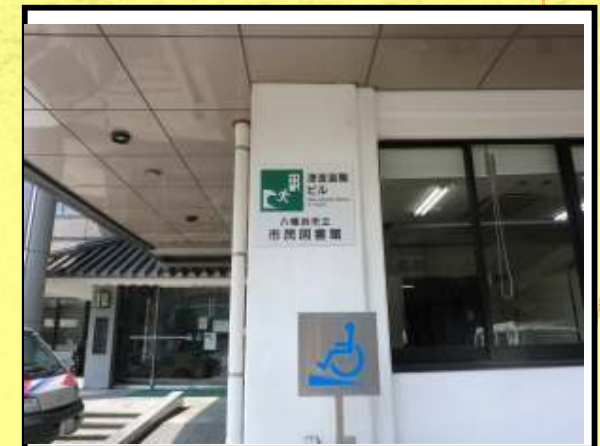
津波避難ビル
