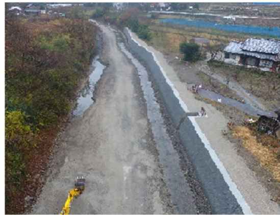
妙之谷川（西条市、H30.9.27～9.30発生、環境保全型ブロック積護岸工）
