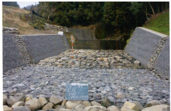
渋谷川（東温市、H13.6.18～7.1発生、環境保全型ブロック積護岸、護床工）
