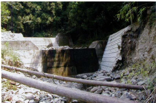
渋谷川（東温市、H13.6.18～7.1発生、環境保全型ブロック積護岸、護床工）
