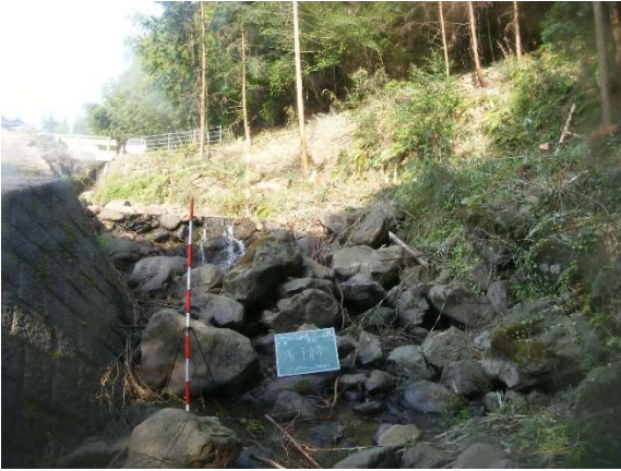
窪野前川（松山市窪野町、落差工+練石積溪流保全工）
