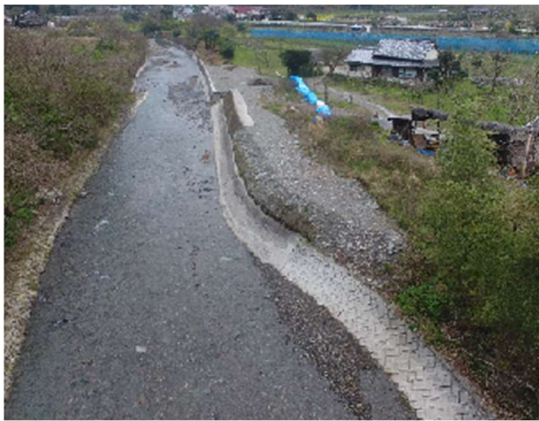
妙之谷川（西条市、H30.9.27～9.30発生、環境保全型ブロック積護岸工）
