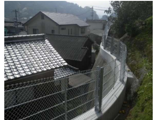
(急)大浦地区（宇和島市大浦、落石防護柵更新）
