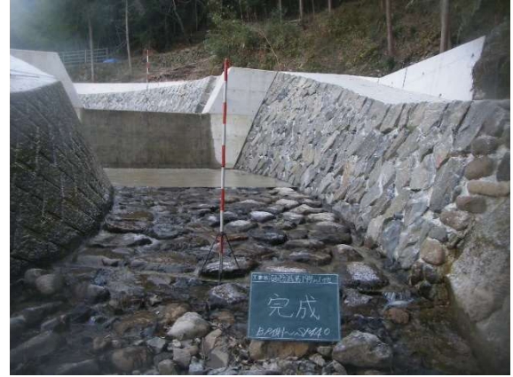
窪野前川（松山市窪野町、落差工+練石積溪流保全工）
