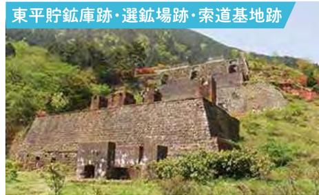
坑道から運び出された鉱石は、貯鉱庫に下ろし選鉱され、索道で端出場エリアに運搬。当時の姿のままの貯鉱庫は「マチュピチュ」の遺跡を彷彿とさせ、神秘的な空間を創っている。
