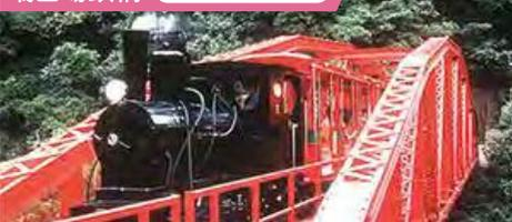
明治26年(1893)別子鉱山鉄道下部線開通時に完成した。美しいボーストリングワーレントラスト(弓弦式)の橋。鉄橋の部材はドイツのハーコート社で作られ輸入されたもので、現在国内に数基しかない。今でも、マイントピア別子の観光用鉱山鉄道として利用されている。
