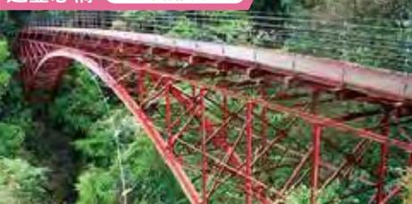
明治38年(1905)長さ48.26m、幅2.4m、高さ23.2mで完成。ドイツのブルバハ社製の鋼材で組まれた日本最古級のアーチ橋。東平エリアへの生活道路として利用され、坑水路も併設されていた。
