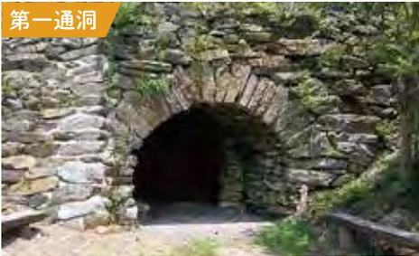
別子銅山最初の通洞(トンネル)。明治15年(1882)に着手し、広瀬幸平指導のもと、ダイナマイトを駆使しわずか4年で完成させた。標高約1,100m地点の水平坑道で全長は1,021mにもなる。
