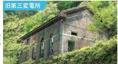
明治37年(1904)建設、赤レンガ造りの変電施設。落シ水力発電所の電気を配電した。明治40年(1907)焼失したが明治42年(1909)再建され、昭和43年(1968)まで鉱業用・社宅用の電力を供給した。
