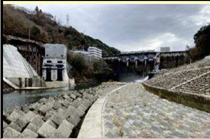
スタート地点：鹿野川ダム直下
