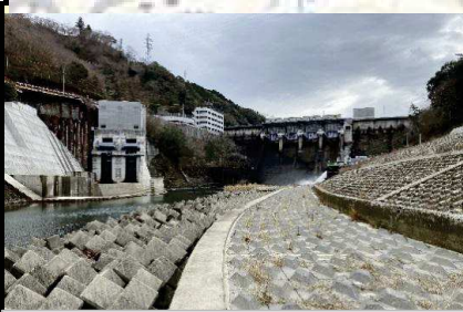
スタート地点：鹿野川ダム直下
