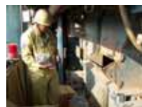
中温化材をアスファルト混合物へ投入
