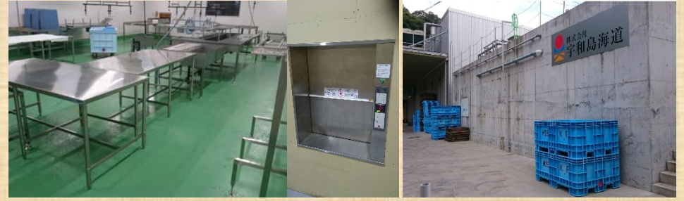
復旧後の加工場と修繕した設備
