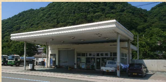
復旧後の写真
