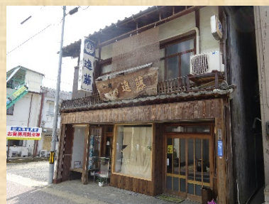
復旧後の写真
