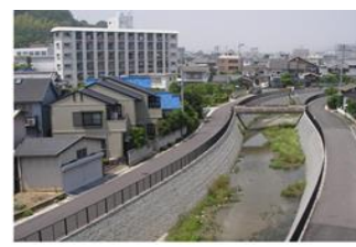
治水対策、堤防補強等の地震・津波対策
