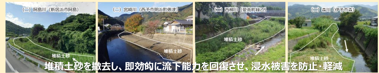
【土砂の堆積状況】
