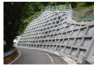
県管理道路の法面対策
