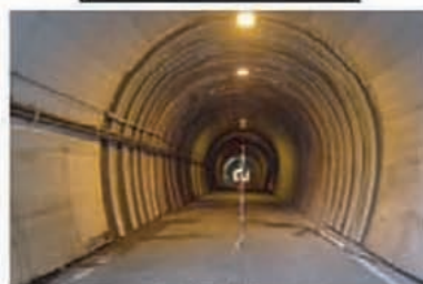
漏水対策工
