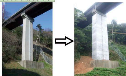
橋脚補強(コンクリート巻立)
