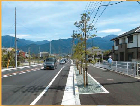
都市計画道路 西町中村線(新居浜市)
