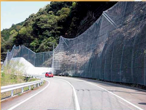
主要地方道新居浜別子山線 災害防除(新居浜市)
