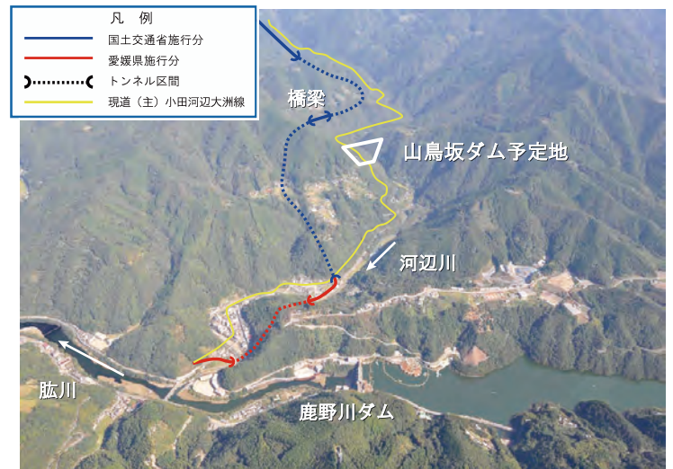
(主) 小田河辺大洲線 山鳥坂ダム付替道路
