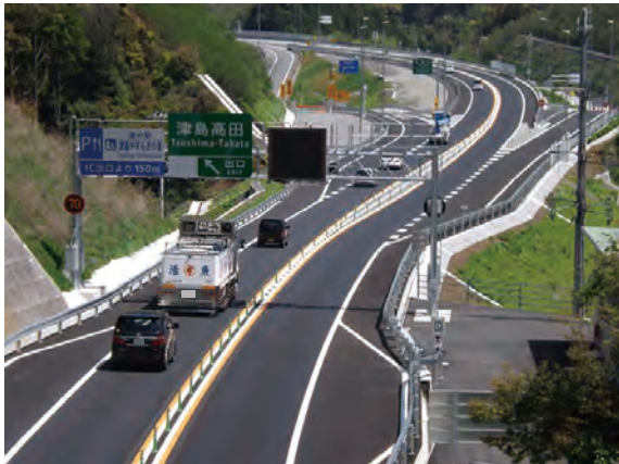
【国道56号 宇和島道路 津島高田IC～津島岩松IC】 (平成27年3月21日開通)
