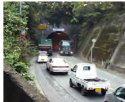
狭隘なトンネル入口において大型車の通過待ちに伴う渋滞が発生
